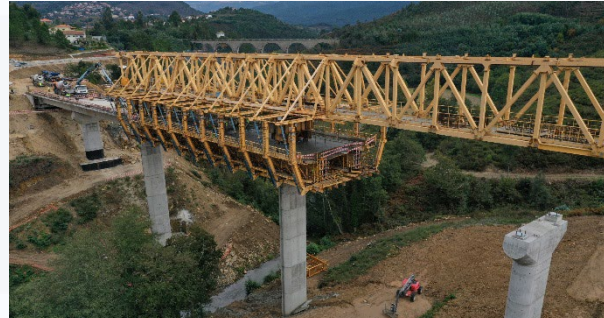
Puente del Tâmega, Mondim de Basto
