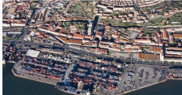
Terminal de contentores de Sta. Apolónia, Lisboa
