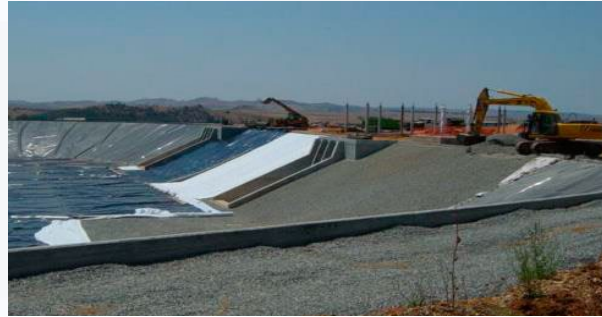
Reservatório da rede de riego do Roxo, Aljustrel
