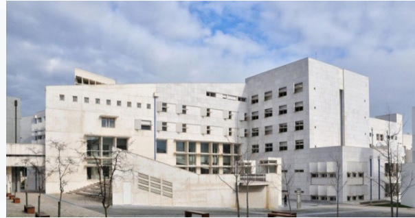
Edifício II do ISCTE, Lisboa *
