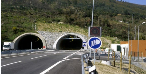
Túnel da Gardunha, Fundão
