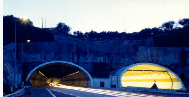
Túnel de Montemor, Bucelas
