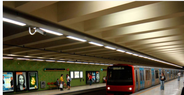
Estación de metro do Lumiar, Lisboa
