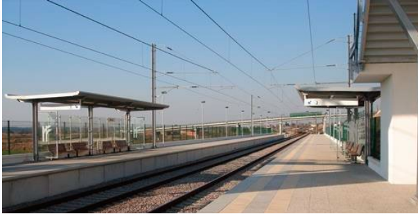
Línea do Norte, Apeadero de Salreu, Aveiro
