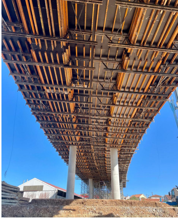
Línea del Oeste, Meleças a Torres Vedras
