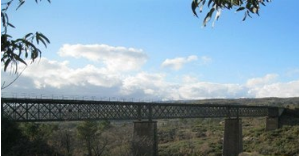
Línea da Beira Baixa, Viaducto de Corges
