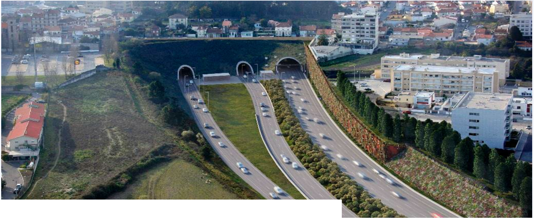
Túnel de Aguas Santas, Maia
