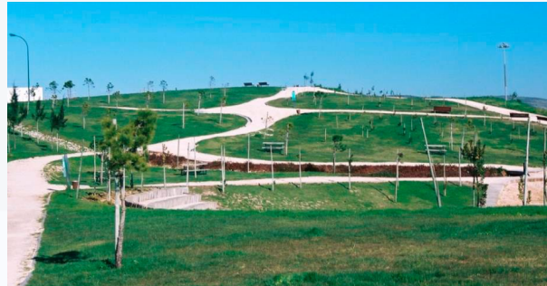
Aterro con captación de biogás, S. Iria da Azóia
